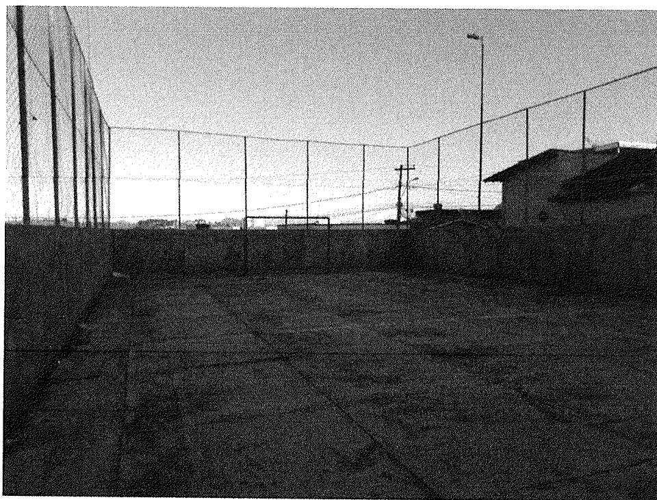
Figura 2-1 – Vista geral da quadra a ser reformada no Bairro Santo Ivo.
